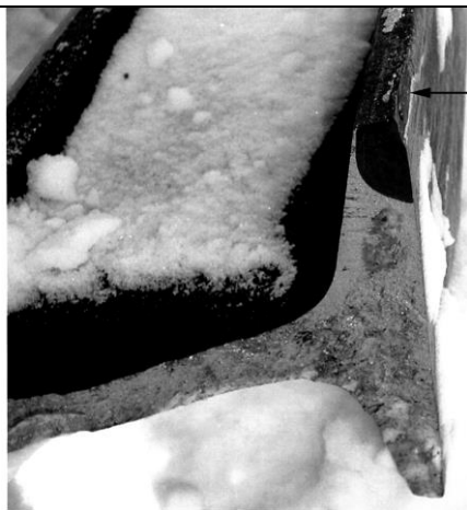
Дефект 76.3/66.3. Излом рельса в эксплуатации от усталостной трещины, возникшей от дефекта сварки (прижог подошвы рельса, показан стрелкой) в зоне сварного стыка.
