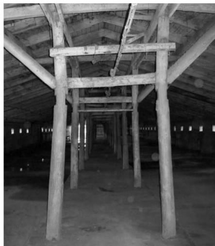
Рисунок 2.4 – Потеря устойчивости стоек в плоскости поперечных рам по оси
