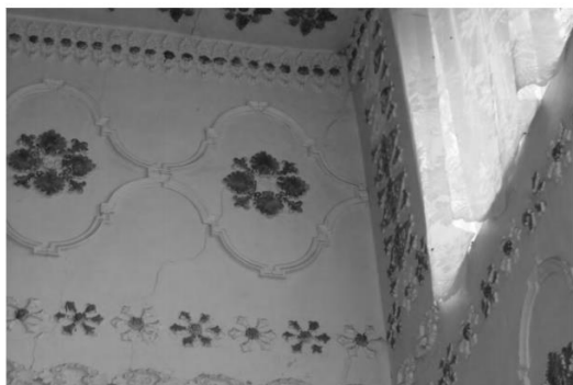
Рисунок 2.3 – Трещина в стене в уровне фанаря по оси В в осях 7–8
