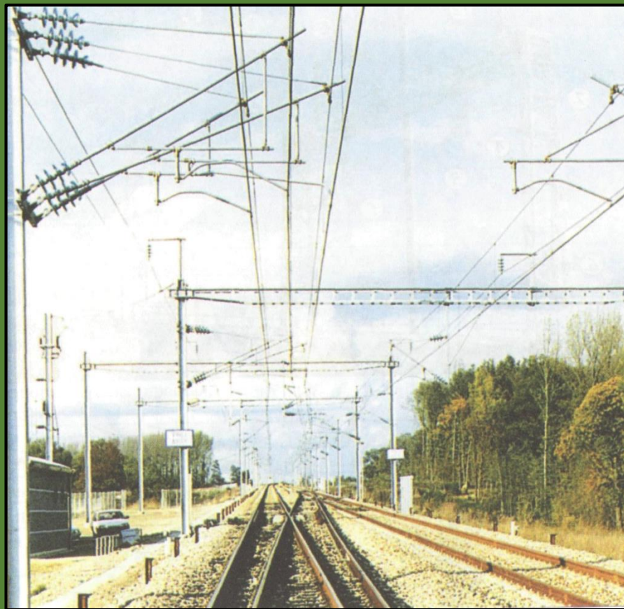
Контактная подвеска на ВСМ с максимальной скоростью движения 300 км/ч в районе воздушной стрелки. Франция.
