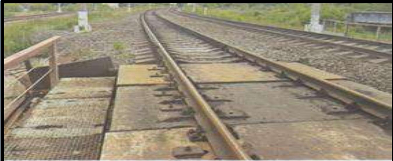
Рис. 3. Композитные плиты
