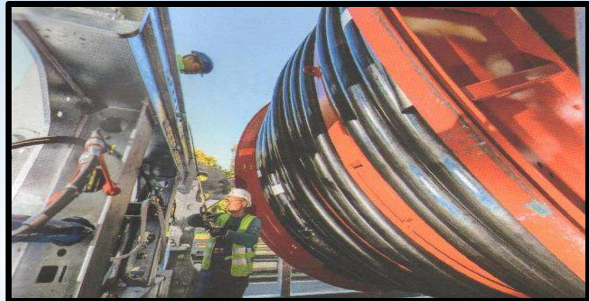
Укладка высокотемпературного сверхпроводящего кабеля в Эссене в рамках проекта Ampacity
