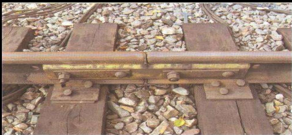
Рис. 2. Изолирующие стыки с композитными накладками
