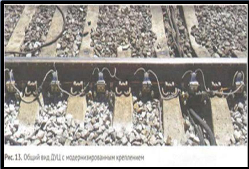
Рис. 13. Общий вид ДУЦ с модернизированным креплением
