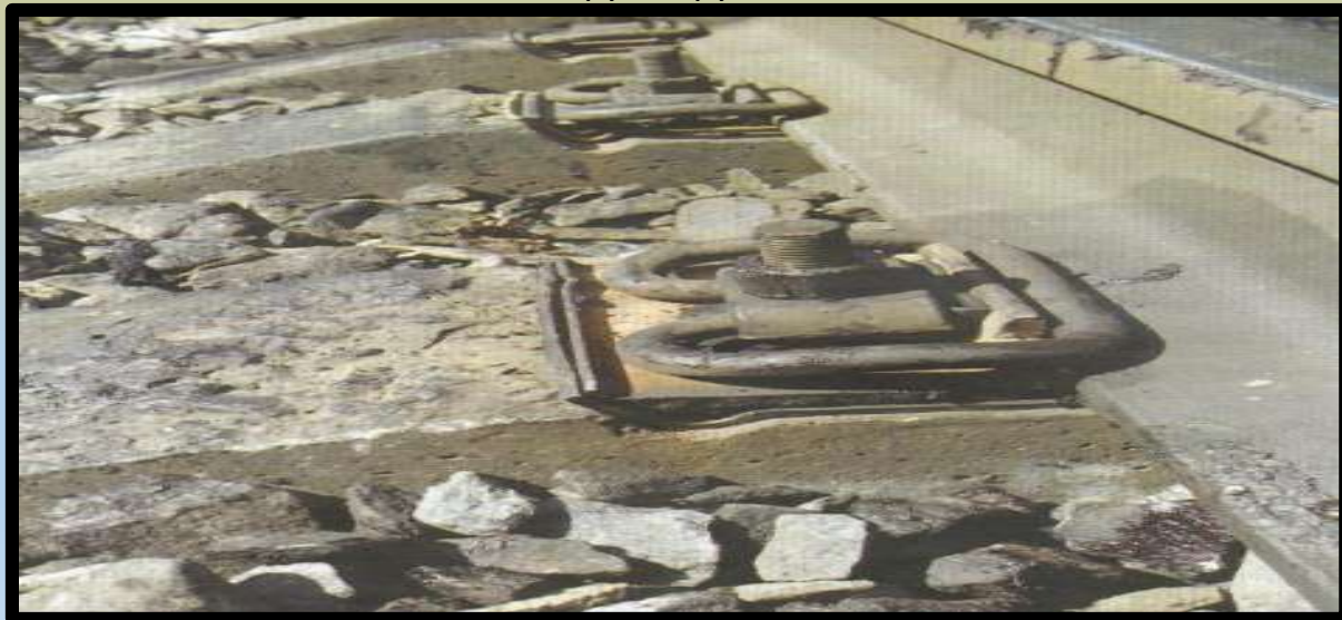
Узел ЖБР-65, отремонтированный с помощью исправной половины подкладки ПШМ
