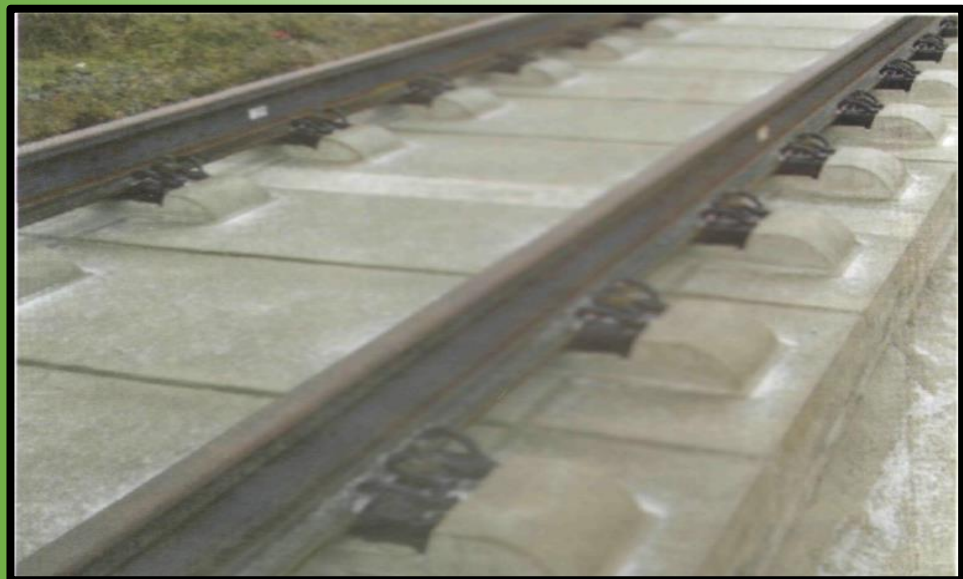
Безбалластная конструкция пути
